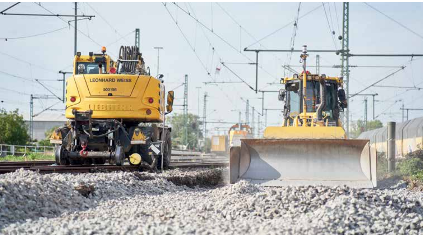
Für den zweigleisigen Ausbau und die Elektrifizierung der Strecke werden neue Bodenbeläge aufgetragen.
